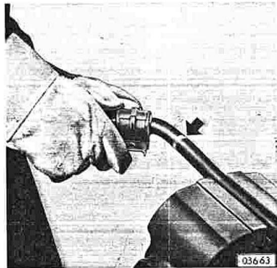
Bei der Montage der Stabilisatorlager ist darauf zu achten, daß die tieferliegende Fläche, wie im Bild, nach hinten zeigt.
