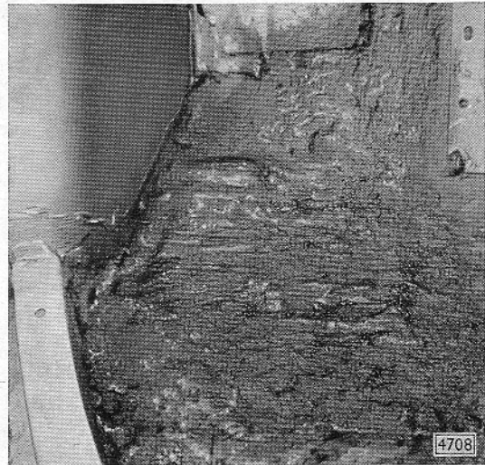
Bild 86 - Auf I-Schweißnaht im Wageninnern Dämpfungsmasse L 000 164/0, soweit diese vom Wagenboden entfernt wurde, auftragen
